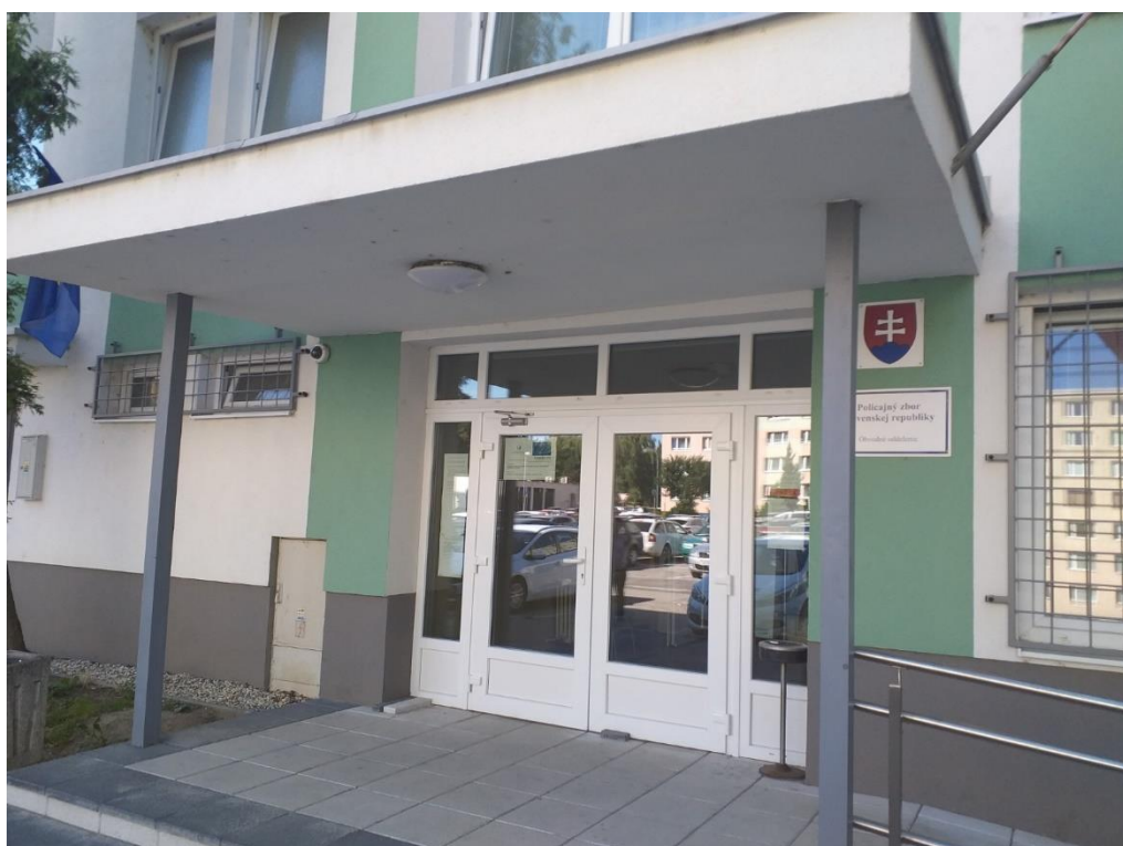
Pohľad severný – vstupné dvere
