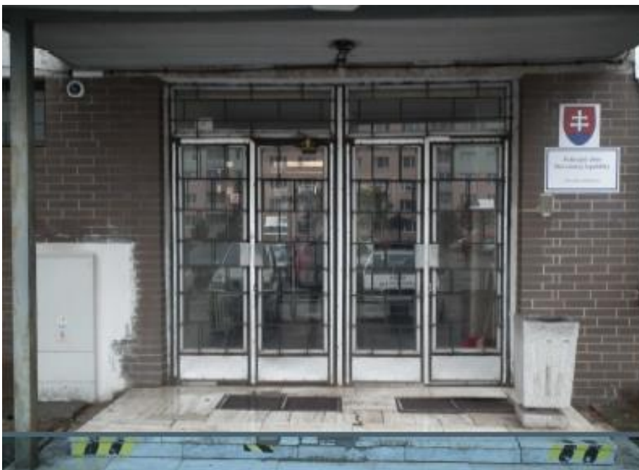
Pohľad severný – vstupné dvere
